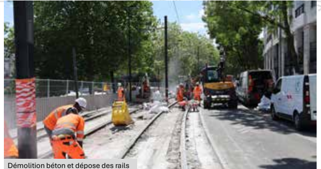
Démolition béton et dépose des rails
