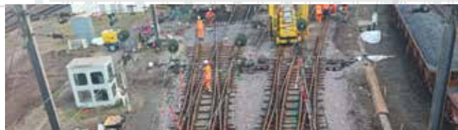
Pose de la 1 ère TJD au PEM LEM
