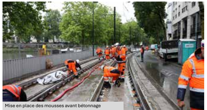
Mise en place des mousses avant bétonnage
