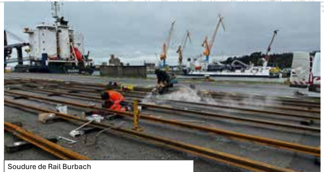
Soudure de Rail Burbach
