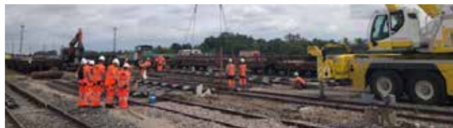
Pose des freins de voie à la Grue
