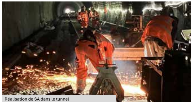
Réalisation de SA dans le tunnel
